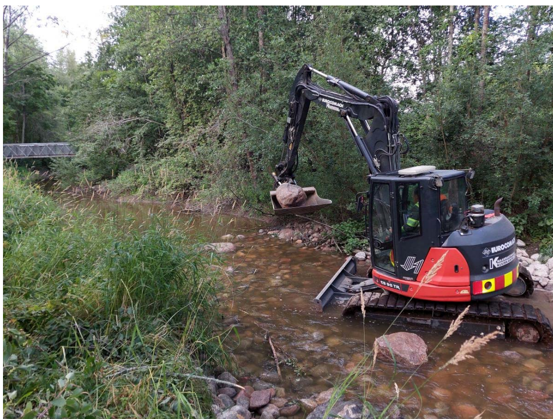
Kuva 8. Viimeisen virta-alueen kunnostus saatiin päätökseen 3.8.2022, jonka jälkeen tehtiin enää vain työmaiden kulkureittien purkamista ja jälkien siivoamista kuivalla maalla.
