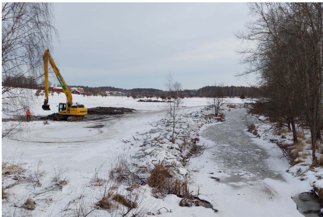
Kuva 5. Erillisenä lisätyönä tehty kaivuutyö käynnissä Espoonjoessa Kirkkokadun yläpuolisella uomaosuudella 18.1.2022.
