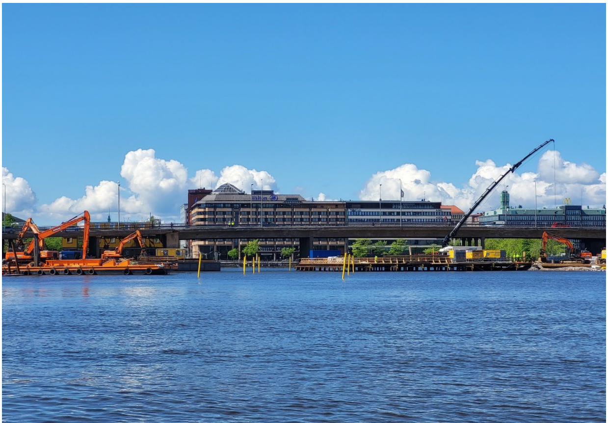
Kuva 2. Hakaniemen silta 30.5.2022. Kuva: Kala- ja vesitutkimus Oy.
