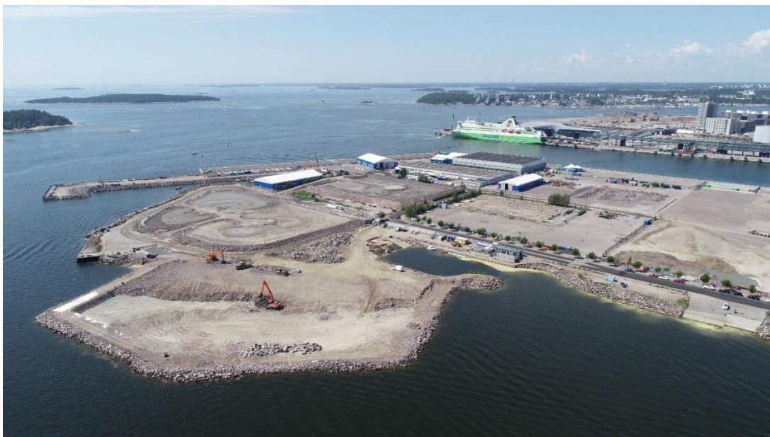
Kuva 1. Hernesaaren vesistörakennusalue vesistötöiden aikaan 11.6.2021.
